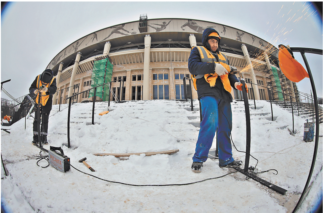
На стадионе идут завершающие работы.
