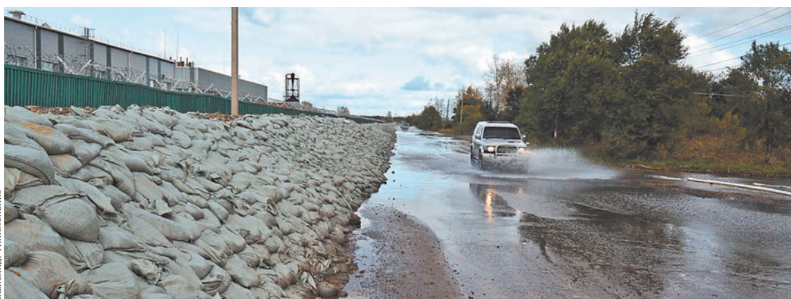
Сооруженные дамбы устояли. Но дороги еще труднопроходимы.
